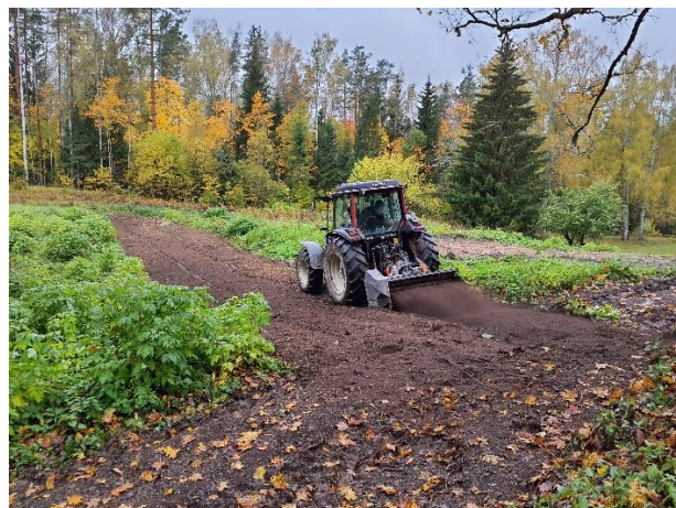
52.b attēls. Vienlaidus celmu un sakņu frēzēšanas darbi. Foto uzņemts 18.10.2023., S.Rutkovska.
